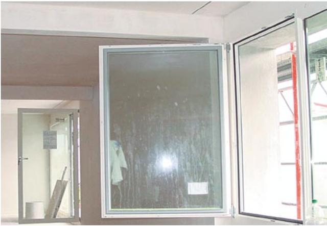
Durch gezieltes Lüften wird der Feuchtigkeitswert des Weissputzes gesenkt. Erst wenn die Restfeuchte unter 1% liegt, ist die Oberfläche bereit für einen Anstrich.
