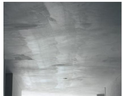
Eine Sinterschicht muss auf jeden Fall mechanisch entfernt werden.
