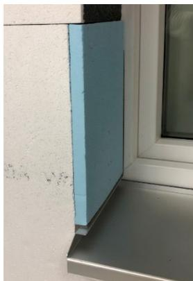
Le collage de la pièce d'ajustement se fait sur toute la surface, en couche mince avec de la colle pour panneaux isolants. Les couches d'enduit contre la bordure de crépissage doivent être découplées par une coupe de séparation.
