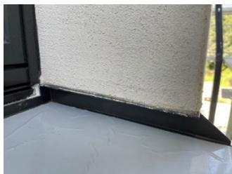
Les étanchéités doivent permettre d'absorber sans dommage les mouvements de la construction et des fenêtres.
