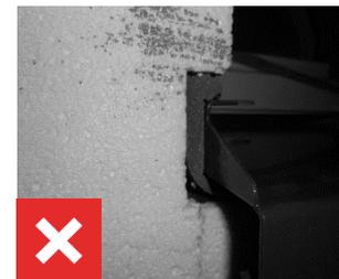
Ne pas poser les bandes en entourant les coins, mais former des angles en appliquant les bandes exactement l'une contre l'autre, avec une légère pression.
