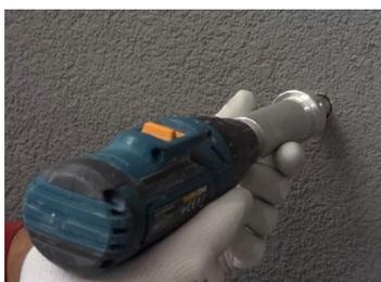
1. Introduire la fraise-CEP dans le trou d'ancrage d'échafaudage, presser fermement et tourner pour obtenir un évidement uniforme de 3-4 mm.
