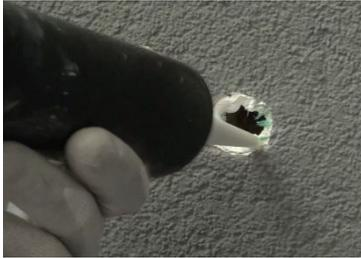
2. Pour plus de sécurité, appliquer une fine couche d'acrylique sur la partie fraisée.
