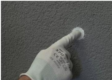
4. Introduire le CEP dans le trou d'ancrage d'échafaudage jusqu'à ce qu'il soit affleuré à la surface du crépi. Eliminer simplement l'acrylique débordant afin d'obtenir un bord propre.
