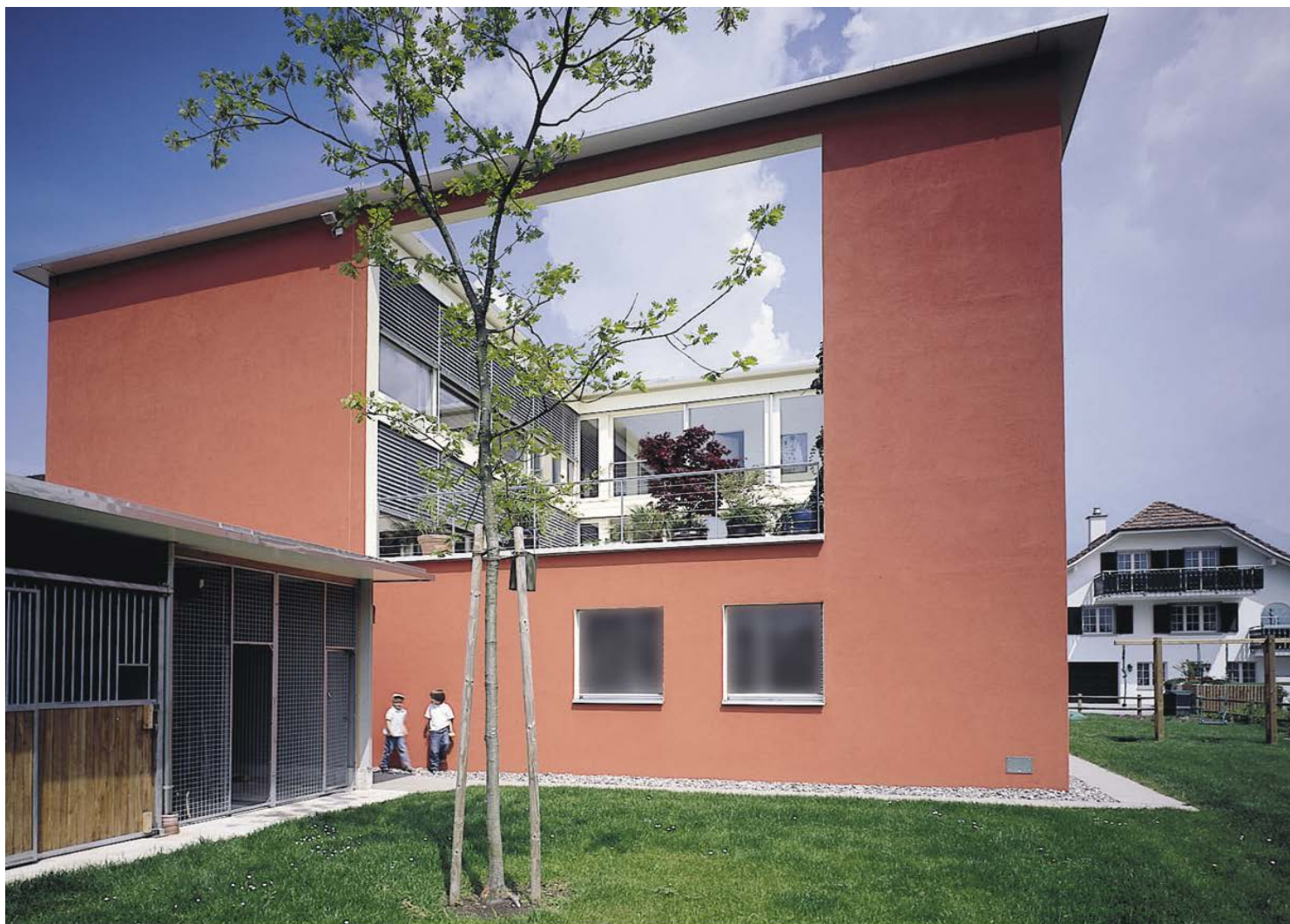
Vorhandener konstruktiver Schutz
