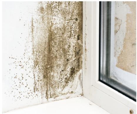
Wird die Zentralheizung in der kalten Jahreszeit z. B. tagsüber runter gedreht, reicht die zeitweise Beheizung am Abend nicht aus, um die ausgekühlten Wandflächen gleichermaßen mit der Raumluft zu erwärmen. Trifft die warme Raumluft auf die kalte Wand, besteht die Gefahr von Kondensatbildung auf der Oberfläche. Auch die Wahrnehmung der Behaglichkeit im Wohnraum wird durch das zeitweise Abschalten der Heizung beeinträchtigt. Die durch das Warm-Kalt-Gefälle zwischen Luft
