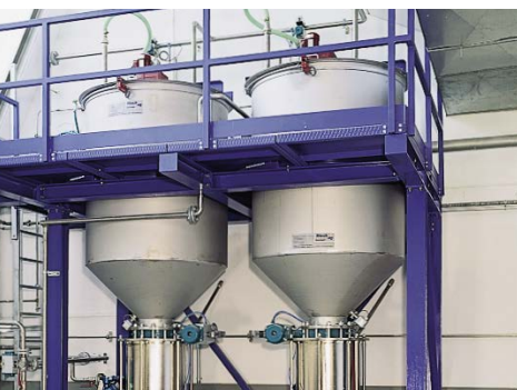
Station d'épuration des eaux usées
